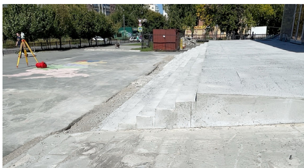
Рис. 1. Общий вид строительной конструкции (крыльцо СГУГиТ)
