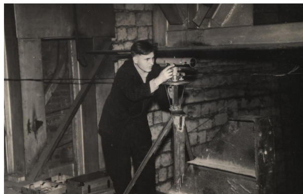
Рис. 1. И. В. Лесных во время работ по съемке подкрановых путей, 1950-е гг.
