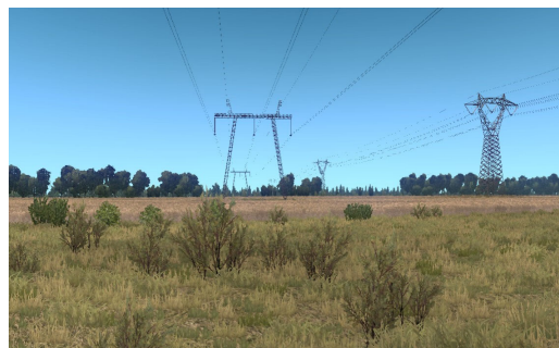
Рис. 5. Участок ЛЭП (вид на уровне глаз)
