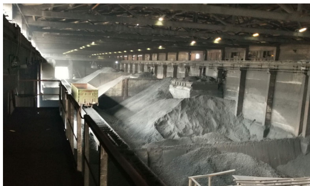
Рис. 2. Закрытый склад нефтяного кокса
