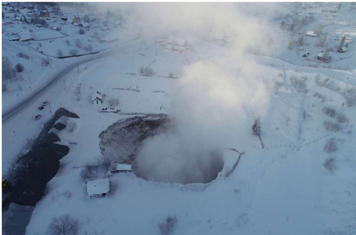
Рис. 2. Провал над участком Подрусловый
