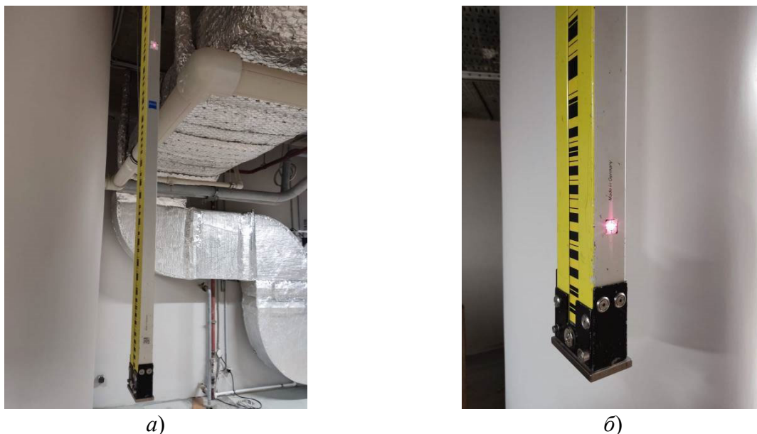
Рис. 4. Наблюдение двух пленочных отражателей, закрепленных на нивелирной рейке. В качестве временного репера выступает одна из деформационных марок потолочно-подвесного типа:
