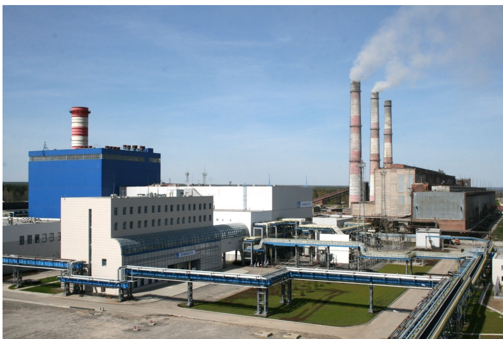
Рис. 1. Общий вид Серовской ГРЭС
