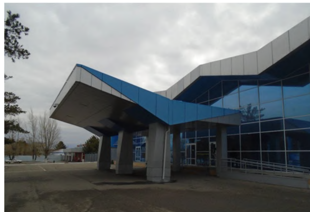
Рис. 1. Состояние международного аэропорта Костанай до реконструкции
