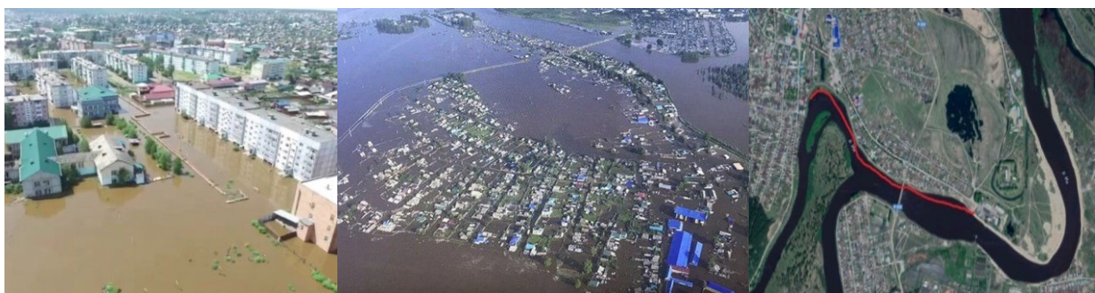
Рис. 1. Фотоиллюстрации последствий наводнения в городе Тулуне (красной линией показано положение разрушенной под напором воды дамбы)
