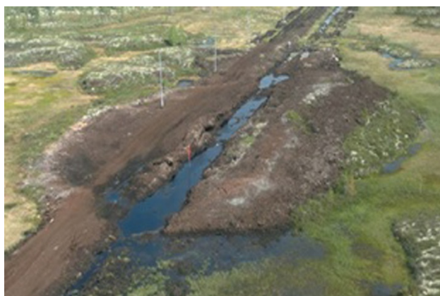
Рис. 1. Бугор пучения на нефтегазовом месторождении на севере Западной Сибири и участок трубопровода с характерным влиянием бугра пучения [2]
