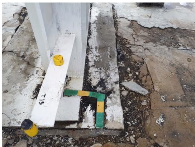
Повреждение конструкции фундамента защитного сооружения
