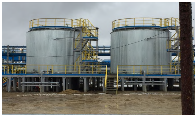
Резервуары на свайном основании в Республике Саха (Якутия)
