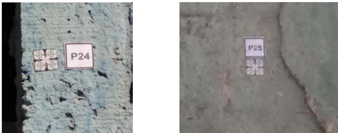
Рис. 3. Способы закрепления опорной геодезической сети
