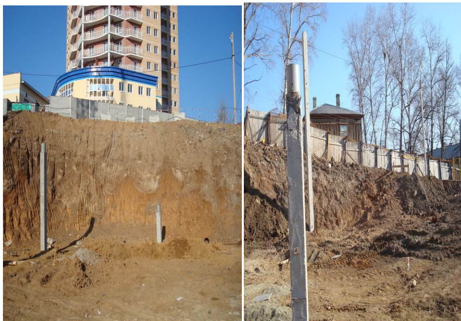
Рис. 2. Последствия слабой изученности инженерно-геологических условий
