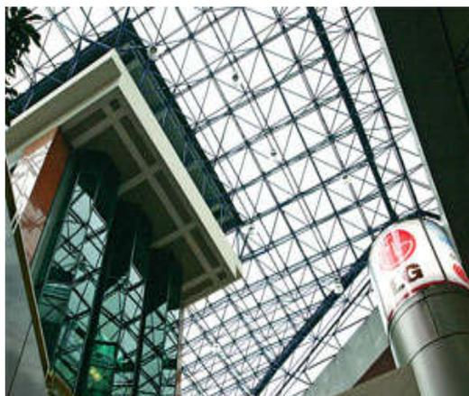
Рис. 7. Пространственные фермы из стали
